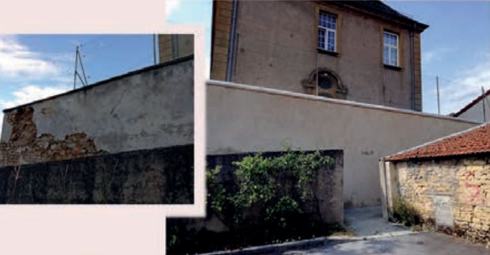
Réfection du mur de l'école
